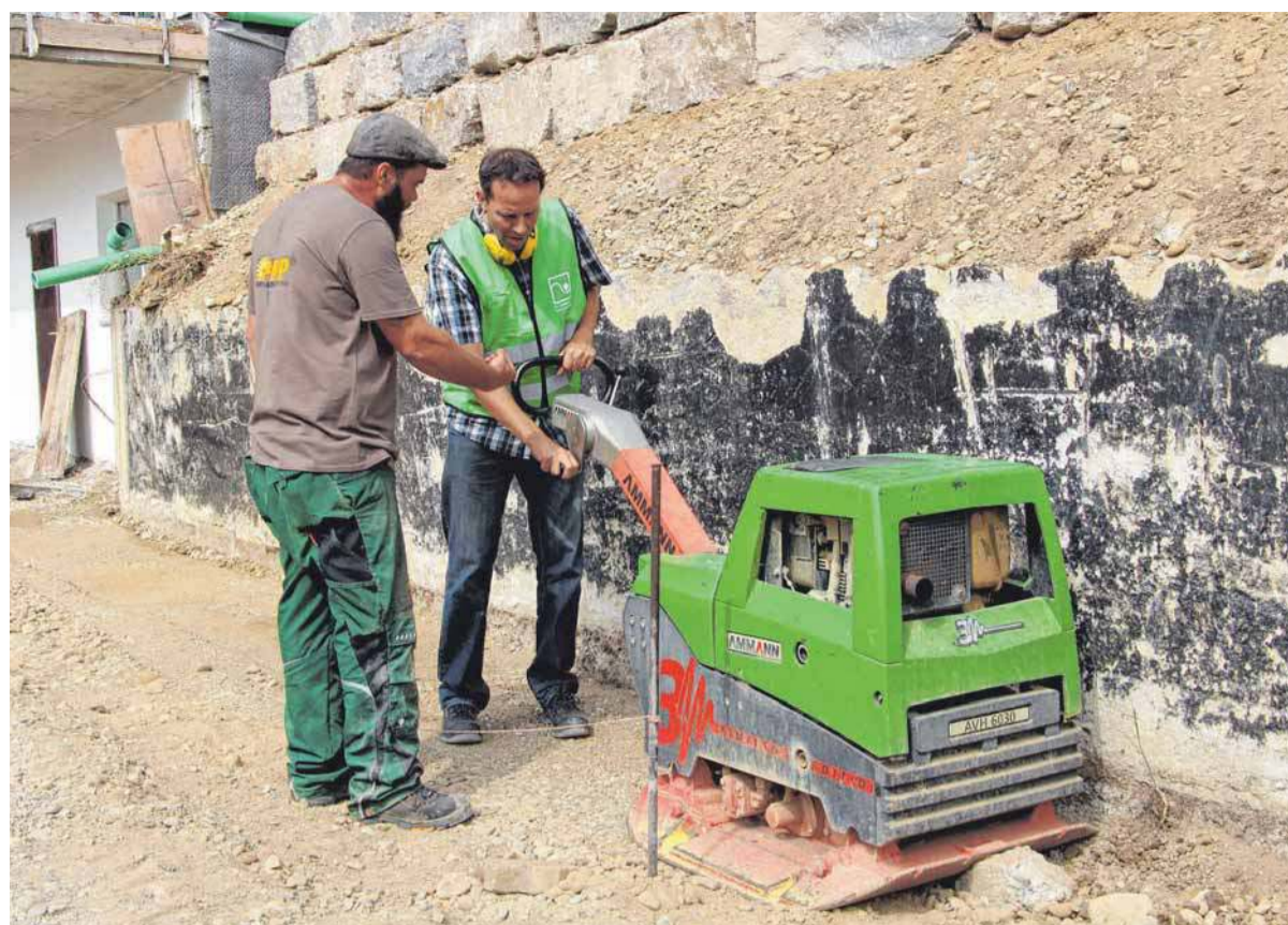
Vorarbeiter Johannes Chavillier (links) erklärt dem Landtagsabgeordneten Thomas Dörflinger (rechts) die Funktionsweise der Rüttelplatte. FOTOS: LEO SUCHAN
